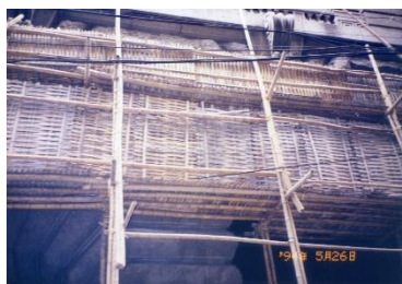
建築現場の足場
